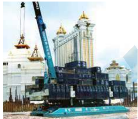
▲ RH1000 на работах по строительству отеля "Гэлакси" в Макао
