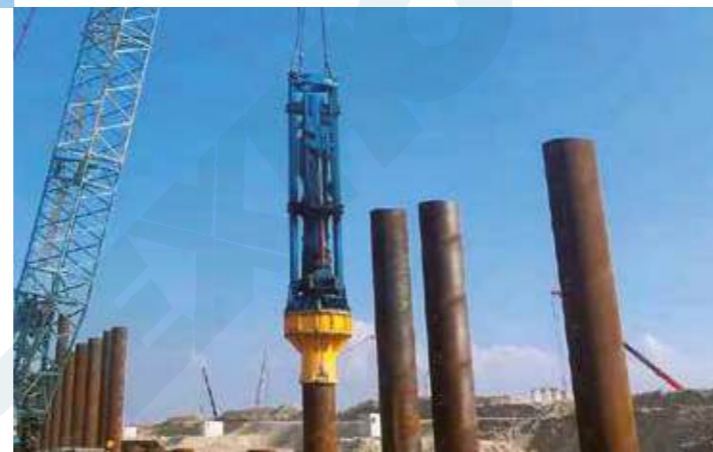
▲ HD180 используется при строительстве порта в Египте
