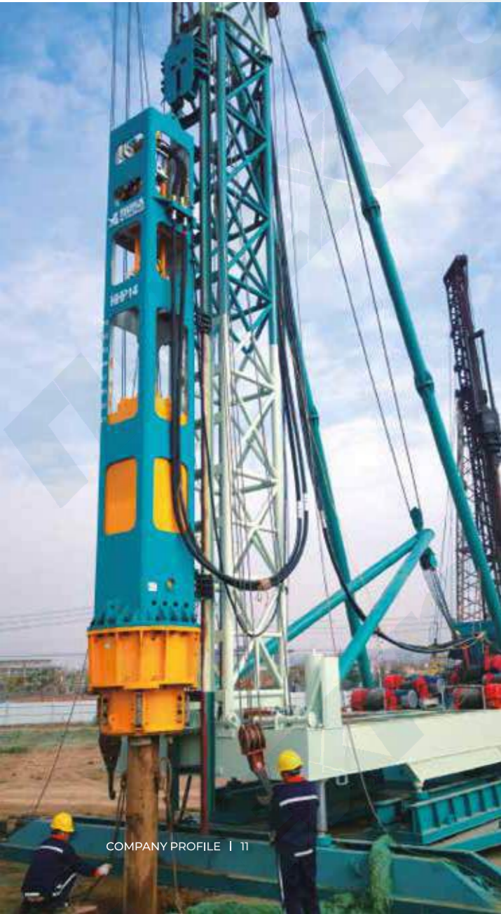
ННР14 на строительной площадке в провинции Гуандун
