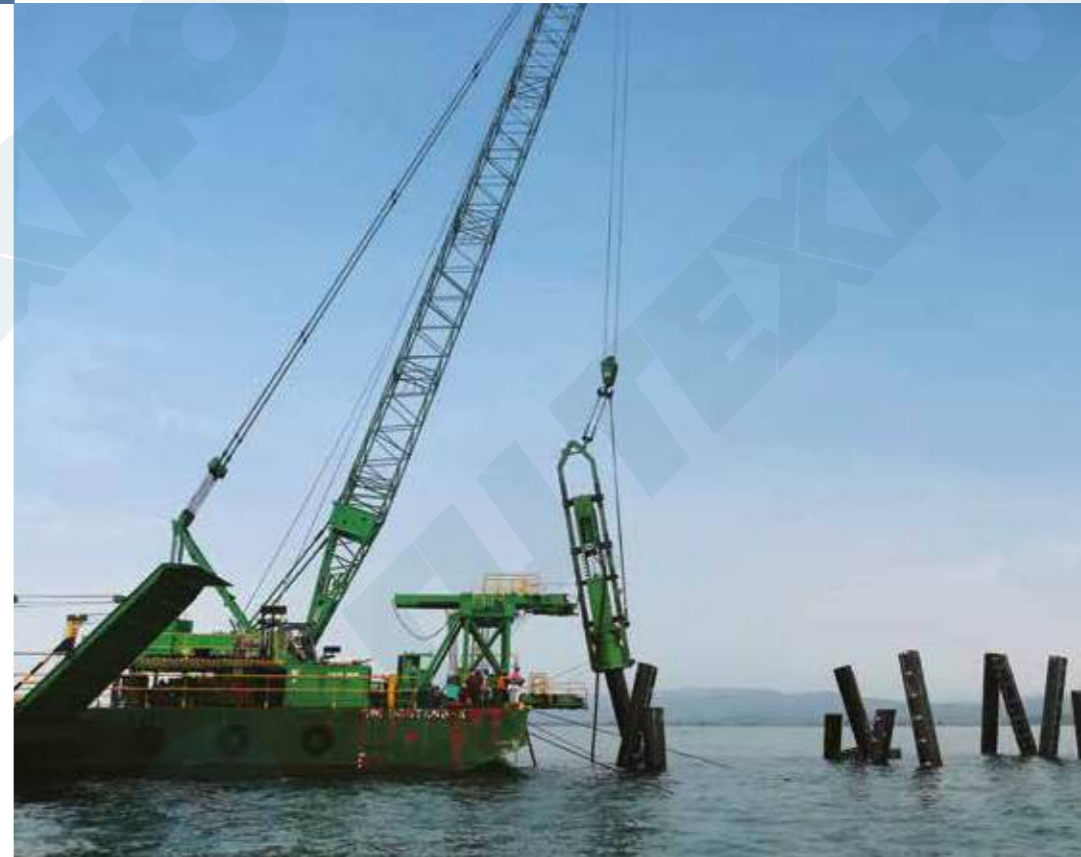
ННР14 для забивки наклонных свай в Индонезии
