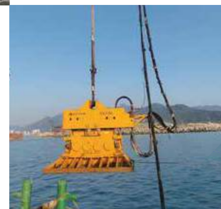
▶ SV400 используется для подводного трамбования в Шэньчжэне, Китай
