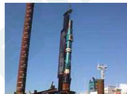
▲ HD50 для подъема и забивки стальных шпунтовых свай в Эстонии
