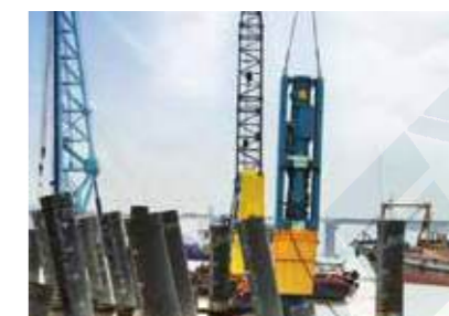
▲ HD160 используется при строительстве порта в порте Наньша, Китай
