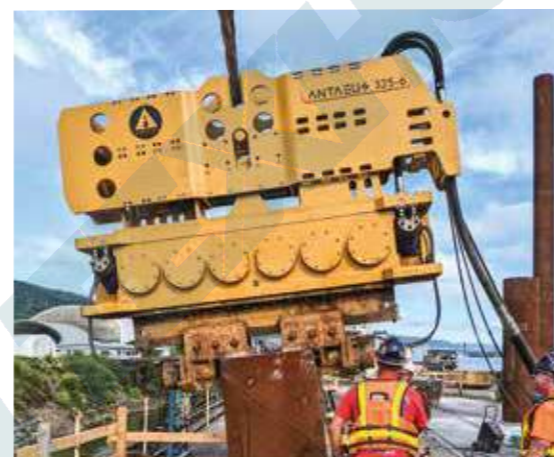
▲ SV325-6 используется для установки наклонных свай в США
