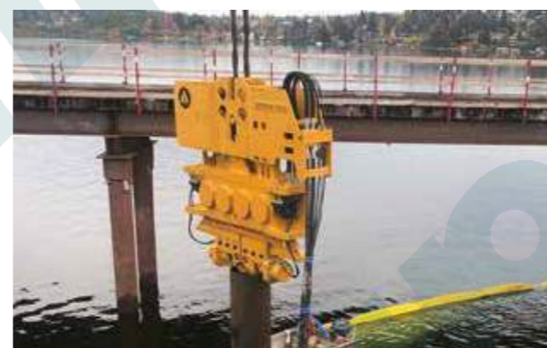
▲ SV325-4 используется для строительных работ по основанию моста в Канаде
