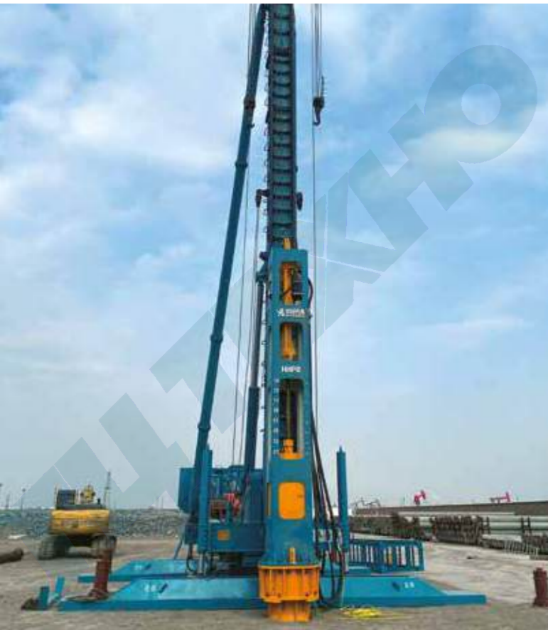
▲ JB62N+HNP8 на строительных работах проекта порта в Тяньцзине
