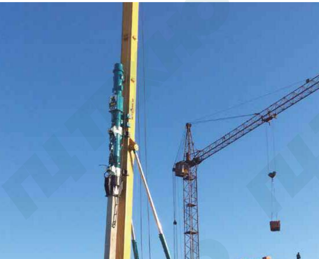
▲ HD19 с копровой установкой на гусеничном ходу LH40 на строительных работах в России
