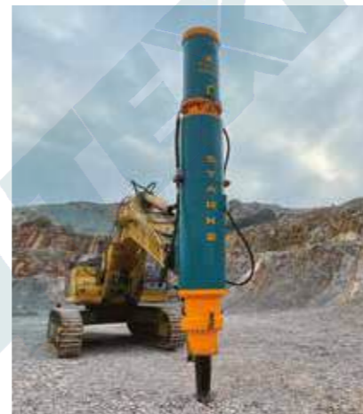
▲ HHR100 на строительной площадке
