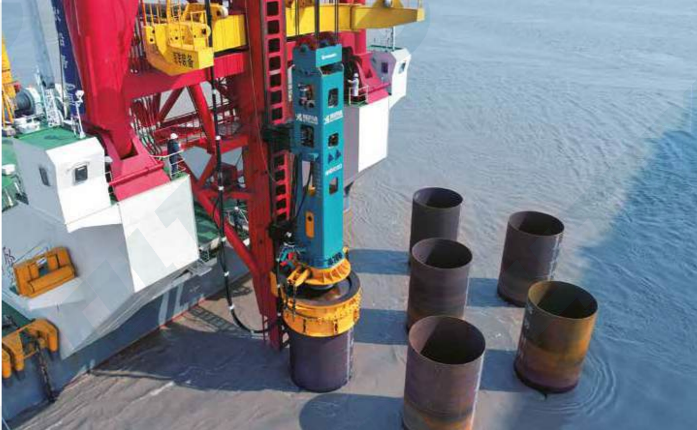
ННД1000 подходит для строительных работ с крупнейшим в Китае плавучим копром (Шуйсиньци № 1).
