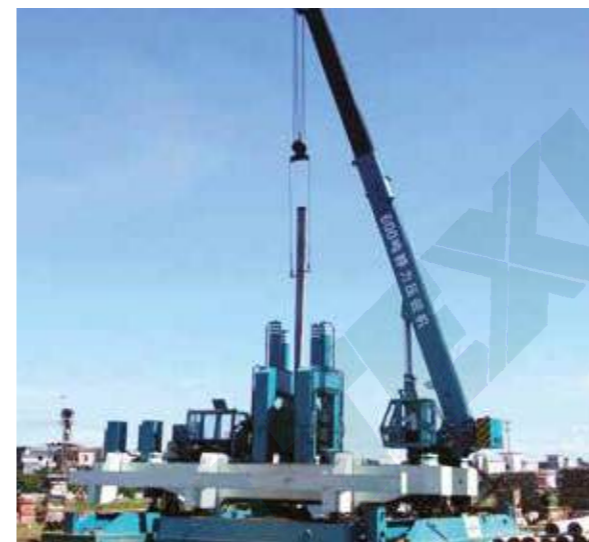
◀ RH600 на строительных работах на строительной площадке в Китае
