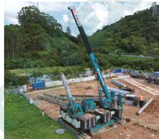
▲ RH350X при установке наклонных свай под углом 30° в р-не Байюнь, Гуанчжоу
